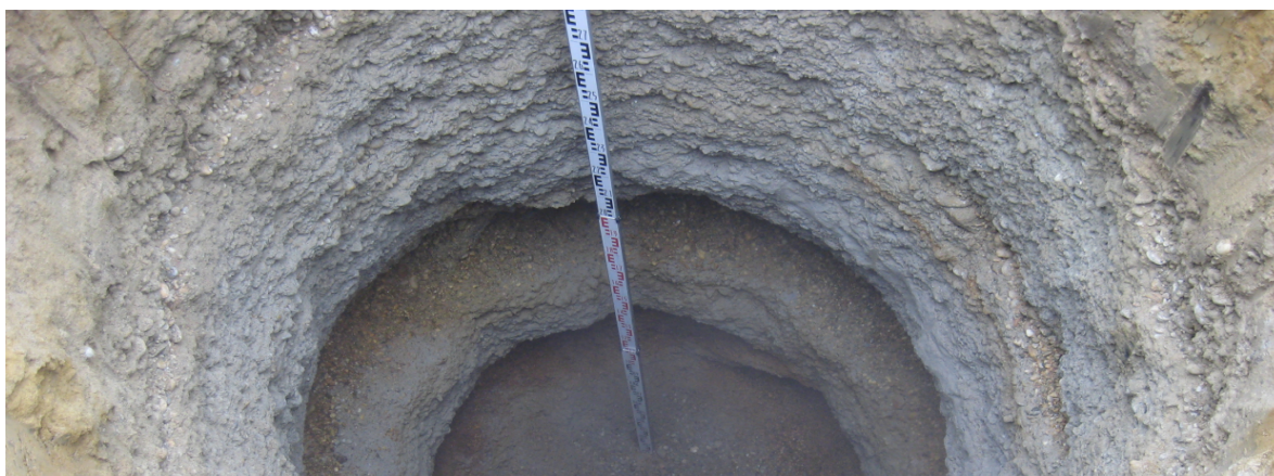
Bohrloch für Brunnenerrichtung
