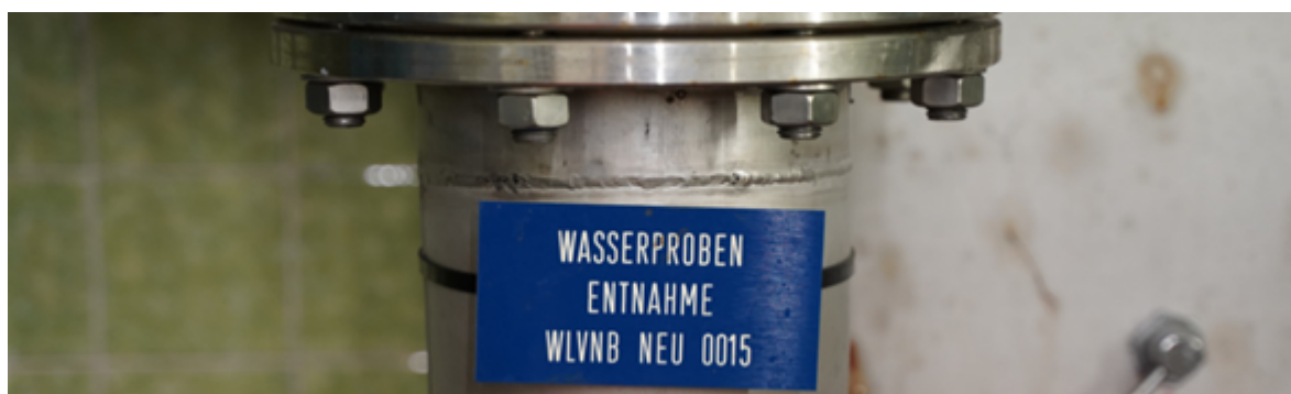
Wasserprobenentnahmestelle
